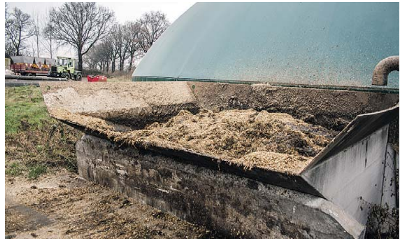
Indføringen til Sauter-anlægget er også uden mekaniske dele. Biomassen presses én gang i døgnet ind i den første tank via denne åbning.
